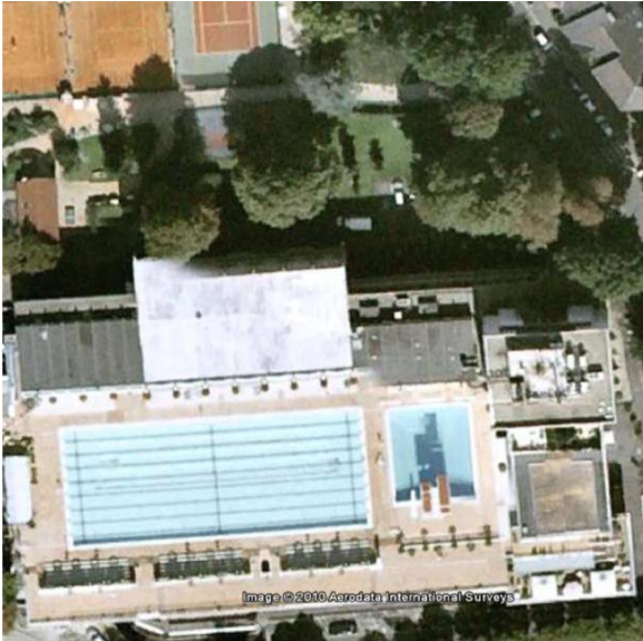
Vue aérienne Google Earth
